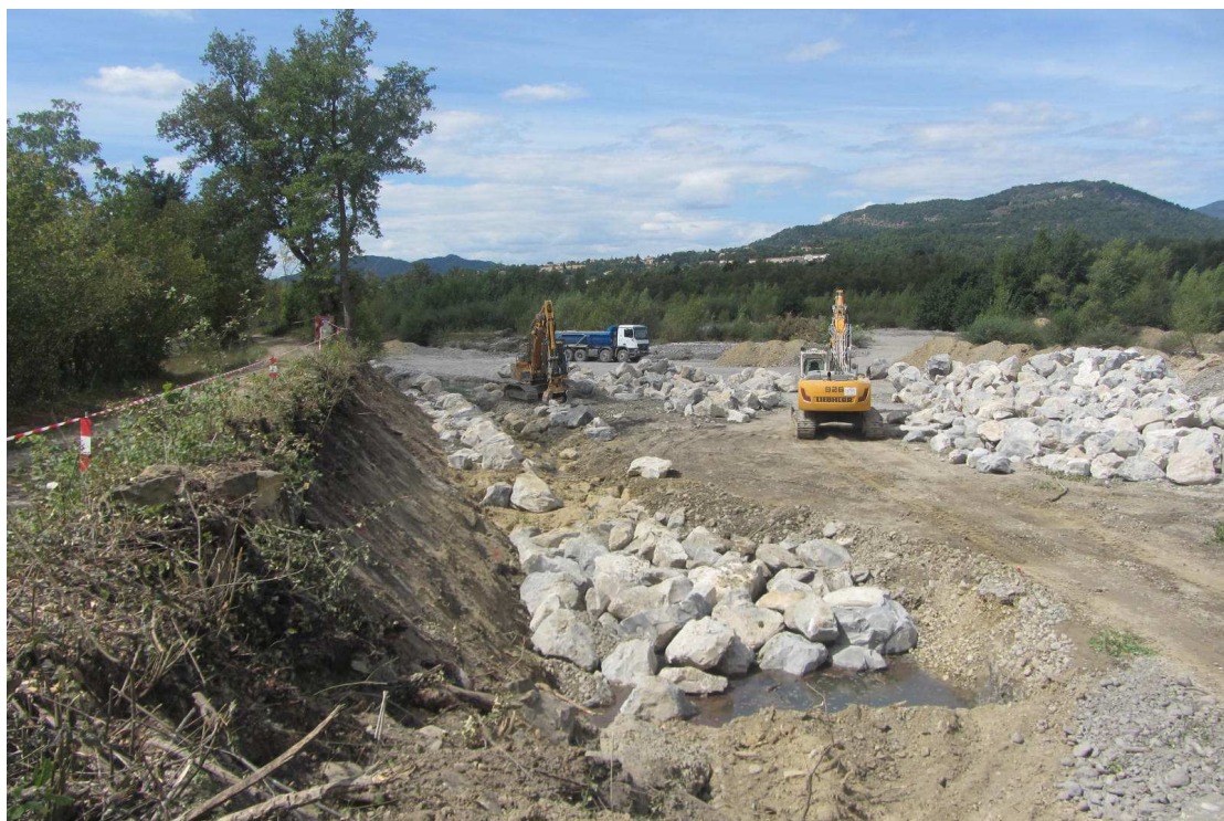
Chantier Digue du Gibassier sur la Commune du CHAFFAUT
